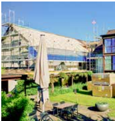
Ein Teil des Daches ist schon mit neuer Isolation und Unterdach versehen.
